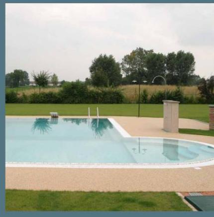
Le dallage MARMO DRAIN Saver est composé de galets soigneusement sélectionnés, spécialement taillés pour former une fine couche (jusqu'à 8 mm), parfaitement homogène et parfaitement respirante et drainante. De plus, les résines polyuréthanes spéciales utilisées, fournies par l'entreprise allemande Hahne GmbH, leader du secteur, ne jaunissent pas et conservent leurs propriétés au fil du temps.
